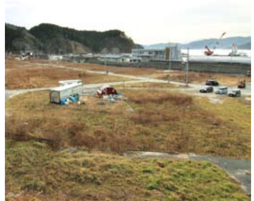
防潮堤の早期整備は町民の切実な願いです (田の浜地区)
