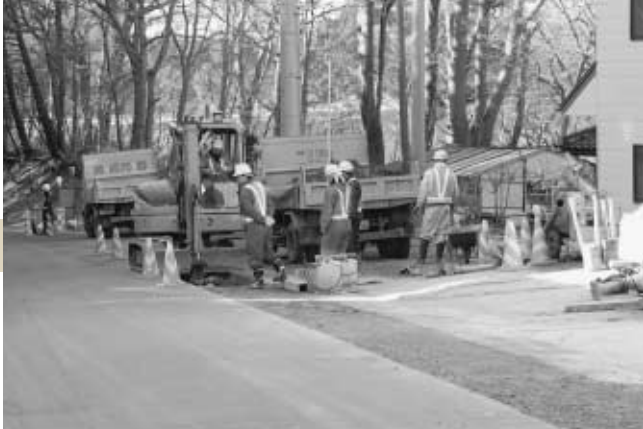
下水道整備は、快適な生活環境の改善と山田の海と自然を守ることが目的です(船越浦の浜地区の下水道工事の様子)
