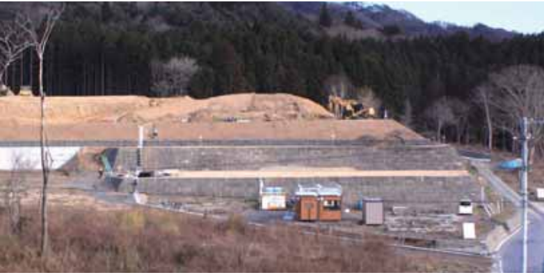
教育現場が動揺しないよう対応します (船越小学校敷地の造成工事の様子)
