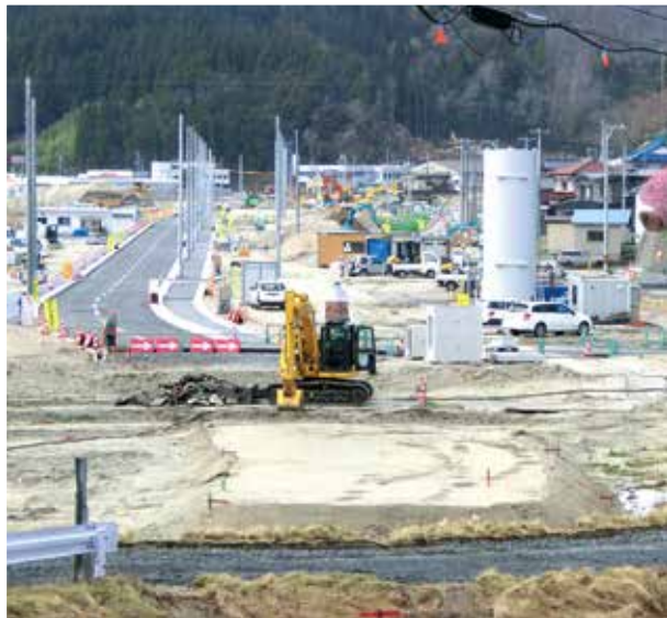
地盤改良工事が進む大沢地区の住宅団地
