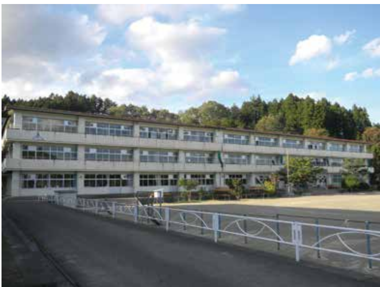
学習環境の充実のためにもエアコン設置を (写真は山田南小学校)
