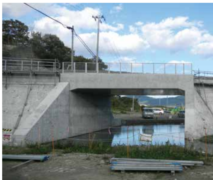
織笠地区の線路に設けられたこ道橋
