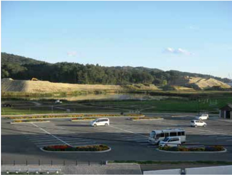
船越（前須賀）地区の土砂仮置場の様子
