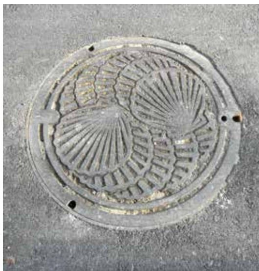
早急な下水道整備が望まれます (写真は町のマンホールのふた)
