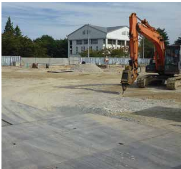
工事が始まった学校給食センター
