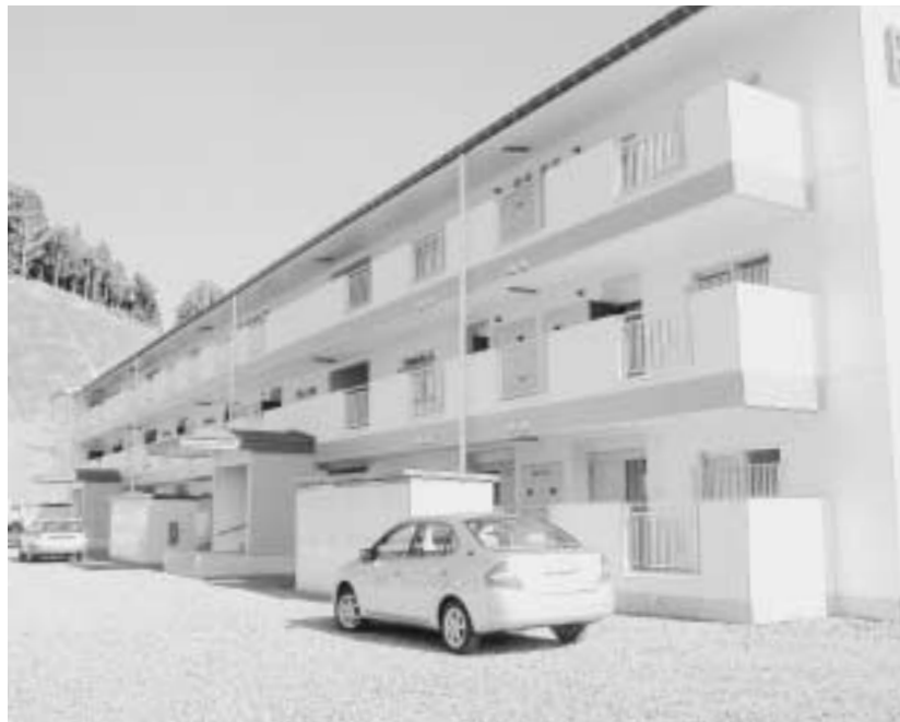
建設計画の見直しが検討されている町営住宅柳沢第1団地
