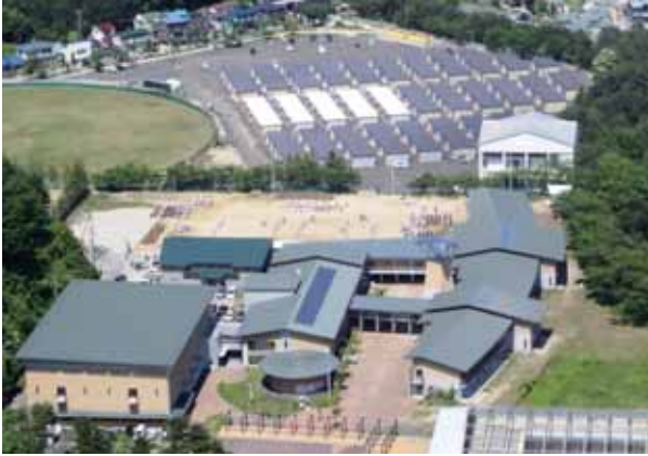
グラウンドに仮設住宅が建設された 山田中学校
