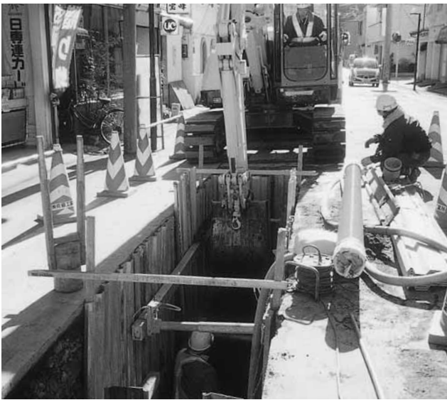
公共下水道山田処理区は平成37年度完成予定で整備が進められています（中央町付近）
