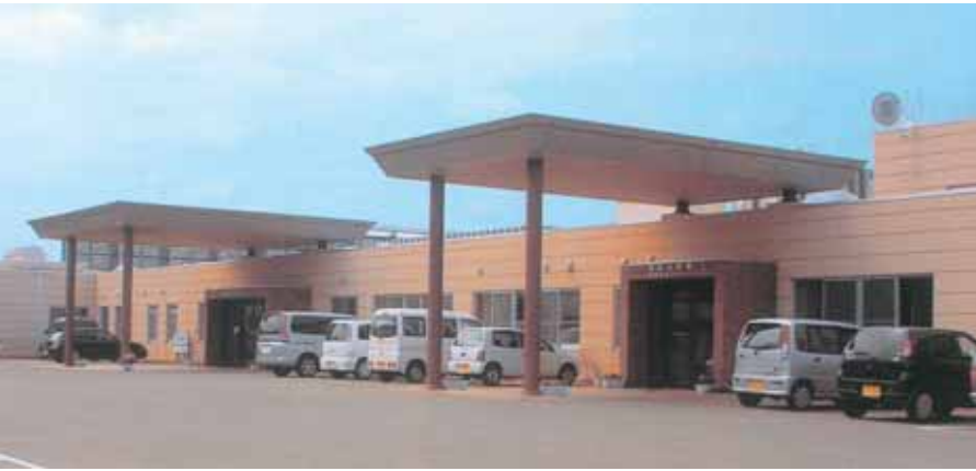
福祉複合施設の高瀬ケアセンター（秋田県羽後町）
