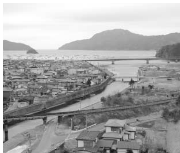
織笠川水門工事は平成22年度完成の予定で進められます（織笠川河口）
