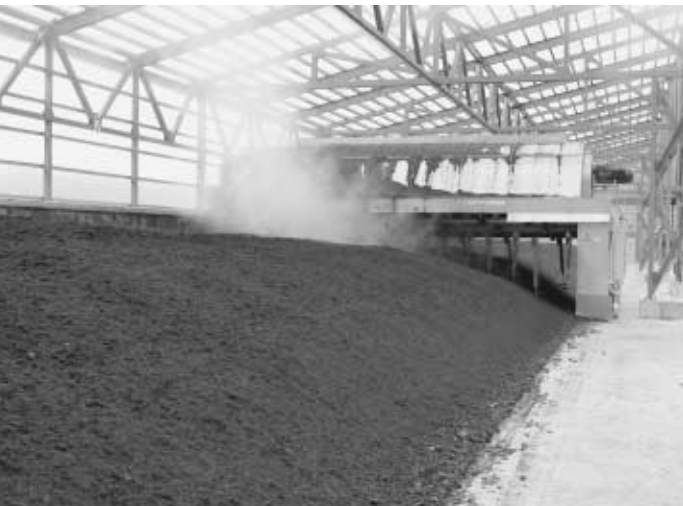
畜産経営の支援策として建設された堆肥センター (豊間根・繫地区)
