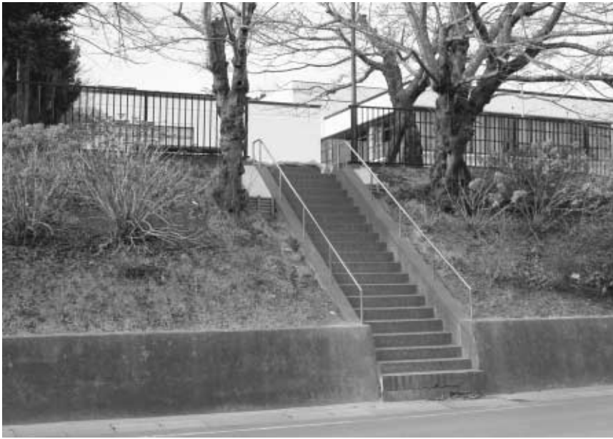
「いきいき公園」前に設置されている階段
