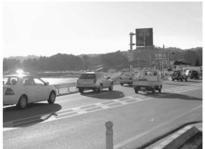
交差点改良で交通渋滞の解消が望まれます（山田インターチェンジ付近の交差点）
