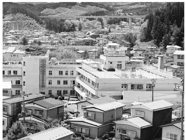
図書館・郷土資料館などへの活用が検討されている「旧山田病院」
