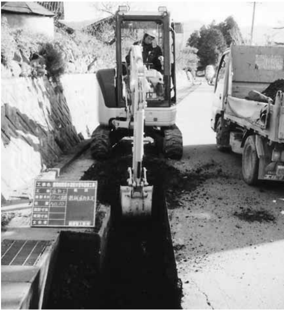
豊間根地区の水道管布設替え事業は、平成22年度まで行われます
