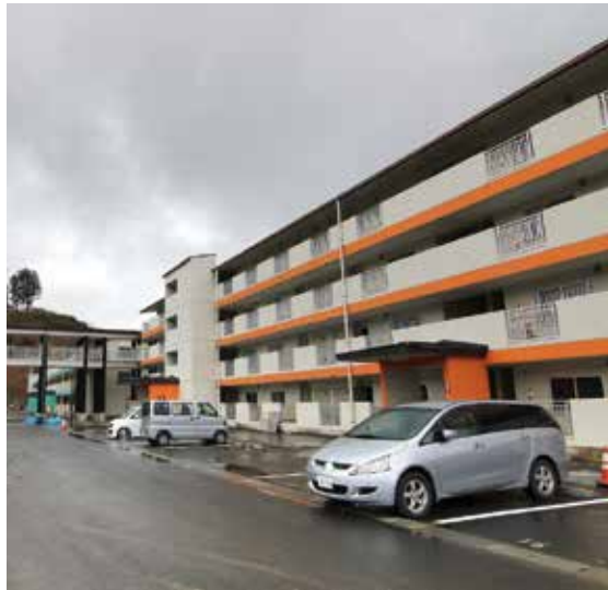
北浜地区の災害公営住宅
