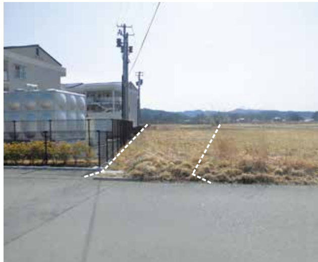
災害公営住宅(写真奥)までのアクセス道路の早期整備が望まれます
