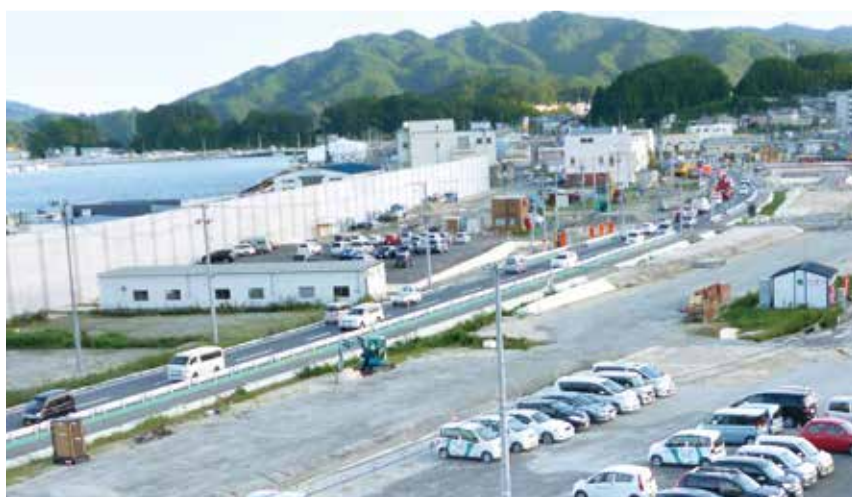
整備が進む国道45号
