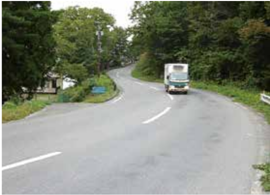
東日本大震災で浸水した町道長林大浦線
