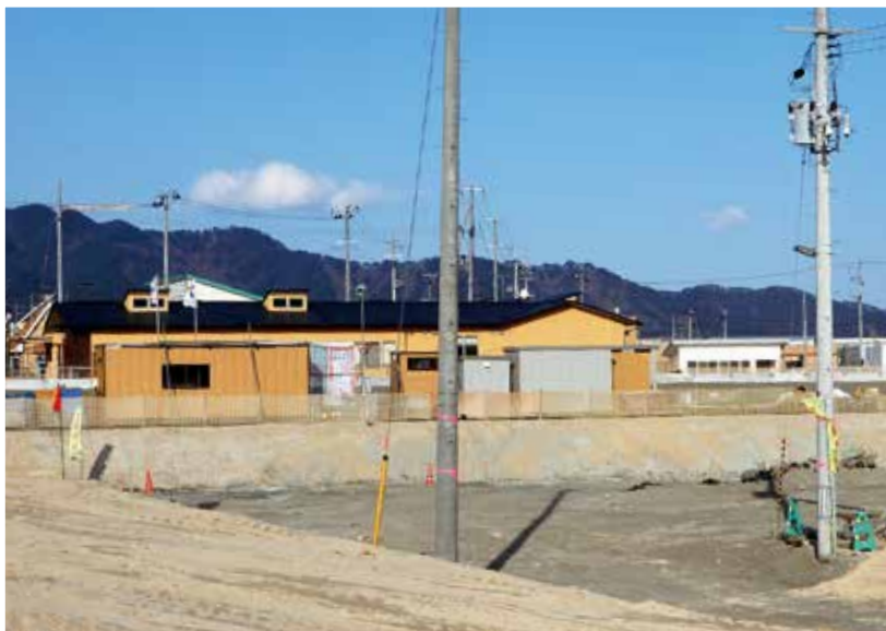
30年度完成予定の飯岡地区集会施設予定地
