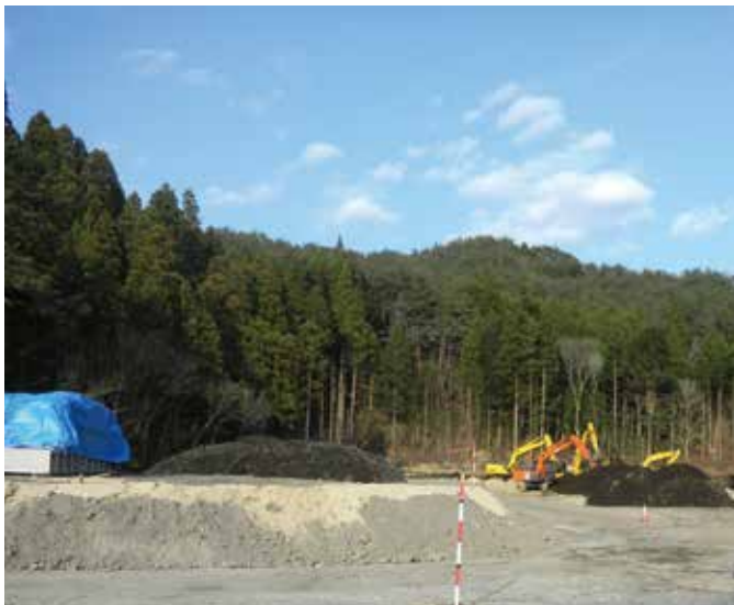
造成中の新斎場建設予定地
