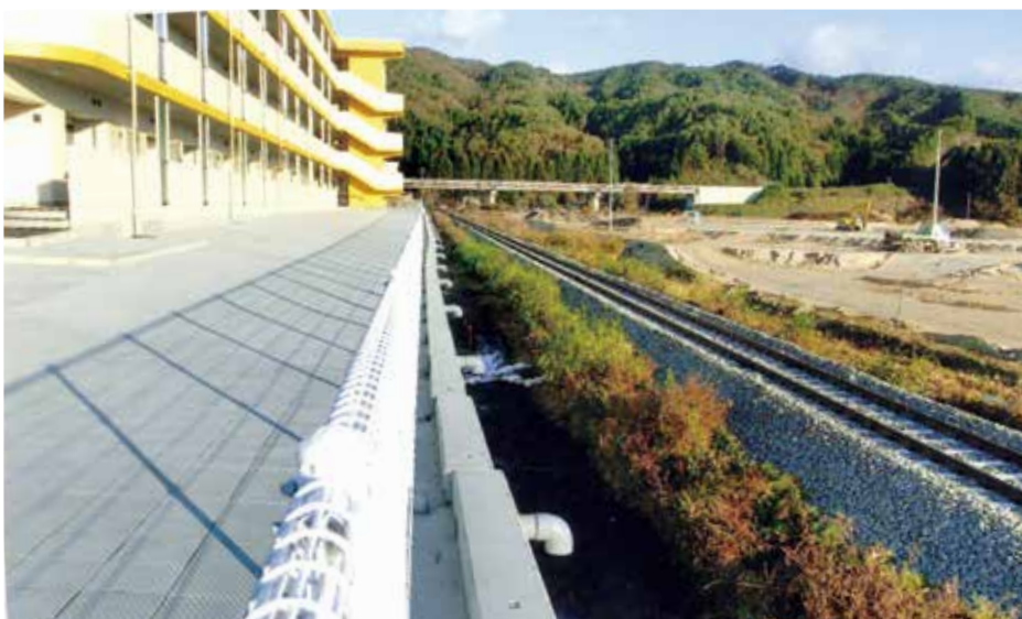
地盤沈下が見られた県営北浜アパート
