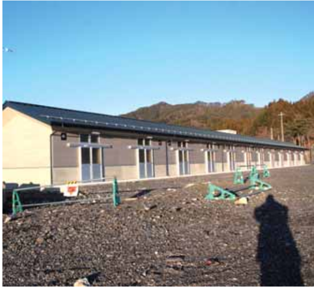
作業保管施設 (田の浜地区)
