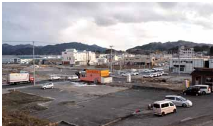
国道45号沿いの災害危険区域
