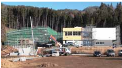
春の開校に向け建設が進む船越小学校
