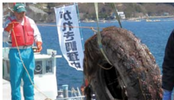
がれき撤去作業
