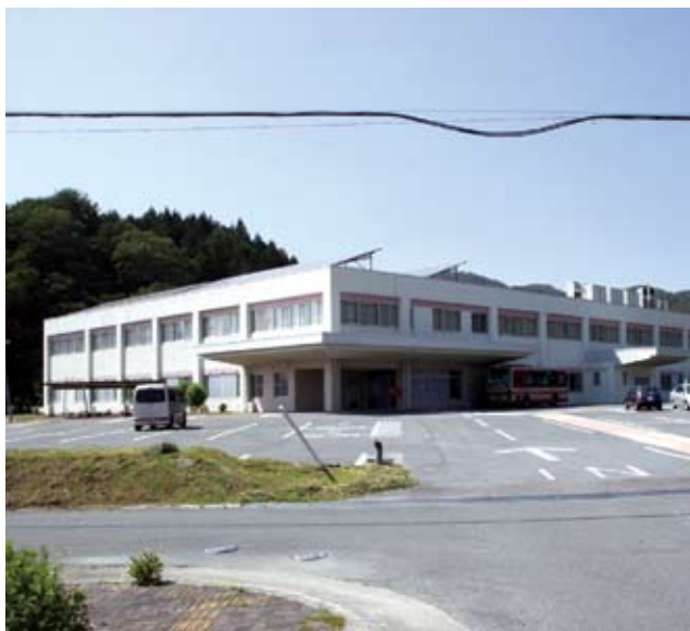
被災した前山田病院
