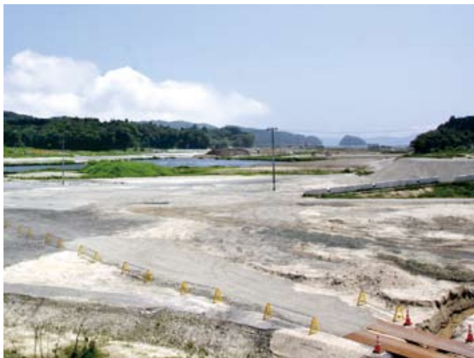
土砂置場として利用する入江田沼周辺
