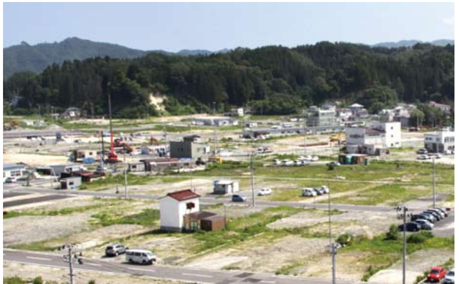
整備が進むJR陸中山田駅跡前の津波復興拠点区域
